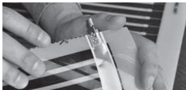
Рис. 4. Установленный на термопленку контактный зажим
