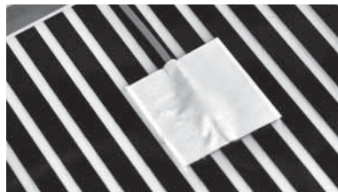
Рис. 16. Установленный и приклеенный датчик температуры пола. Вид снизу термопленки
