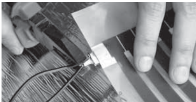
Рис. 11. Надежно зажмите провода в контактном зажиме
