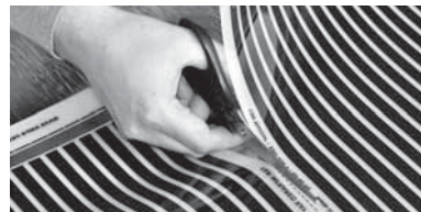
Рис. 3. Разрезание термопленки CALEO по линиям отреза
